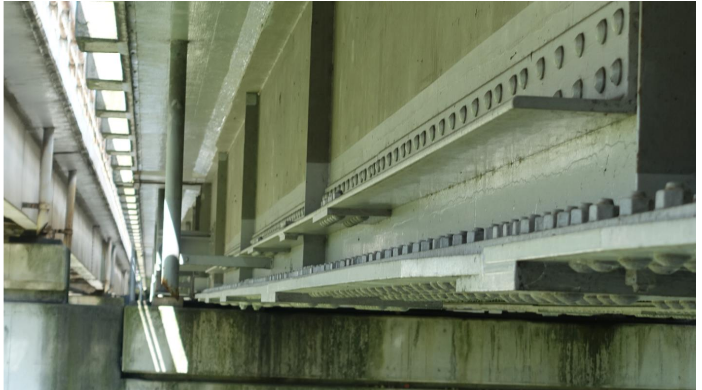
図-17 側径間単純合成桁は、下フランジ補強および下水平補剛材を追 して剛性を高めている。
