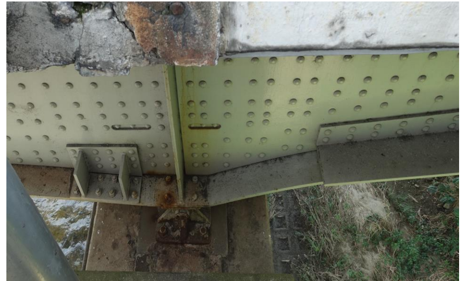
図-21 中間支点下フランジの補強
