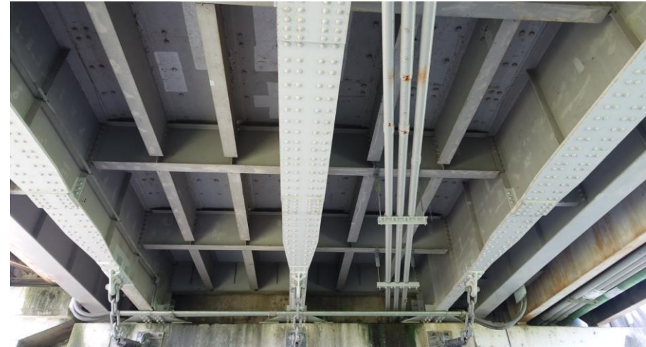
図-13 縦桁横桁追加および鋼板接着で床板が補強されている（現在）
