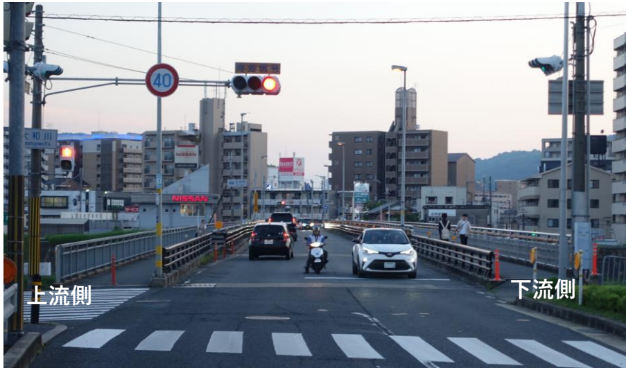
図-12 車道部拡幅工事がなされた現在の写真
