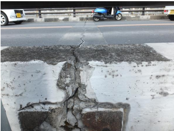
図-16 既に床版には目地補修、 標識柱は移設されている
