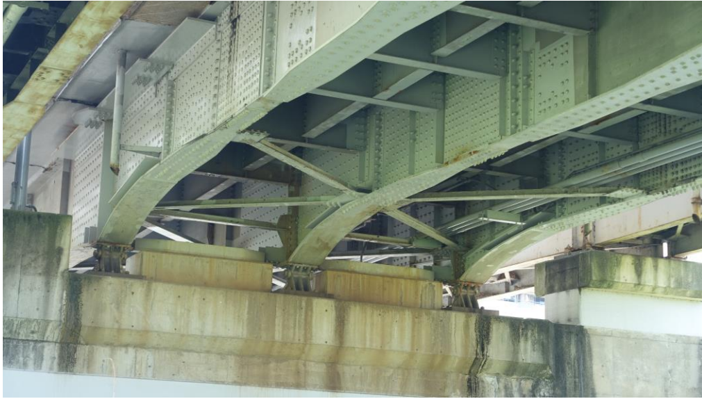
図-18 中間支点上の補強
