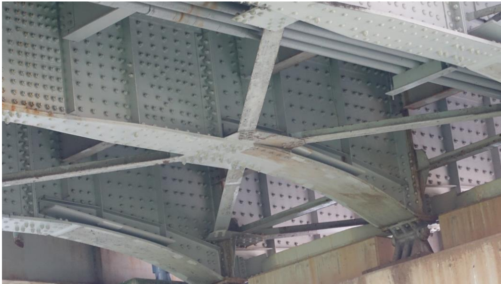
図-20 中間支点ウェブの補強
