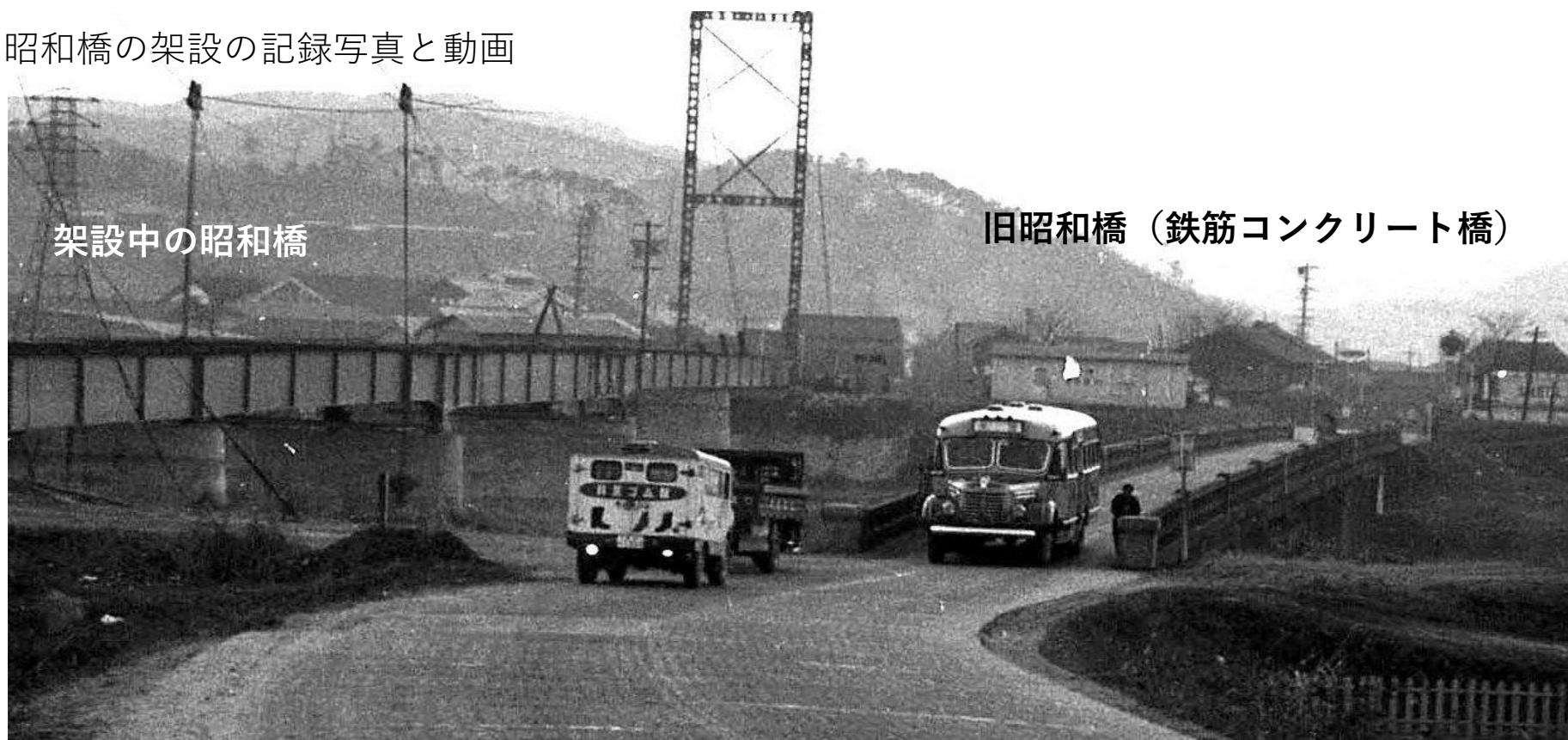
図-6 架設中の昭和橋と旧昭和橋
