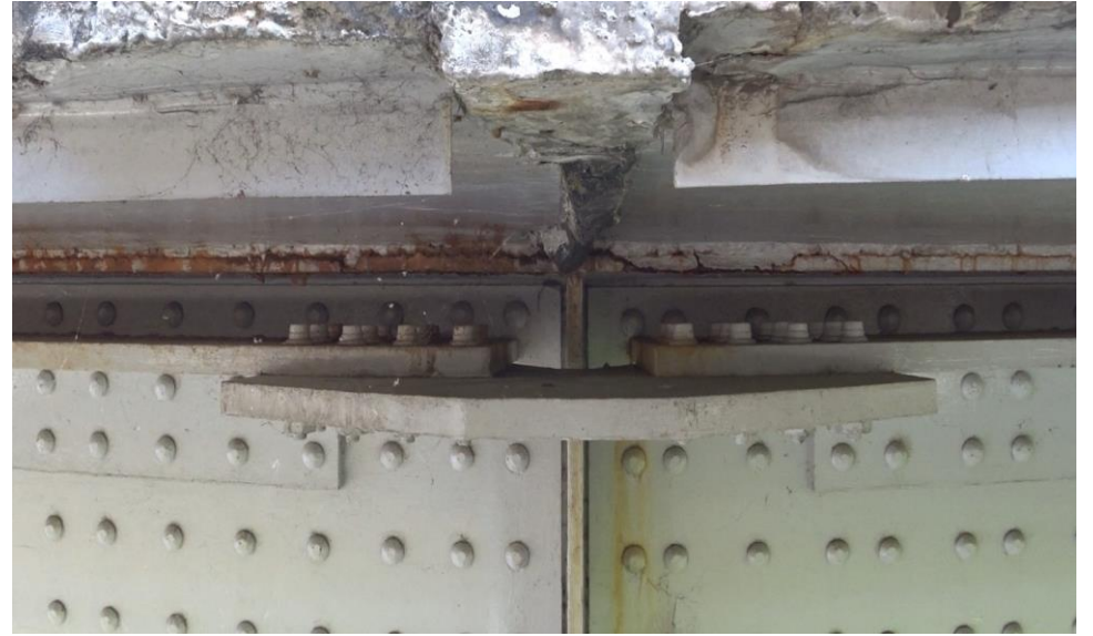
図-19 上フランジの補強
