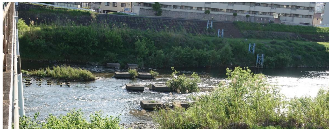
図-8 現在残っている旧昭和橋の橋脚基礎
