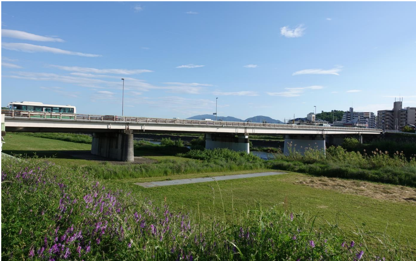
図-23 百年橋梁を目指す現在の昭和橋
