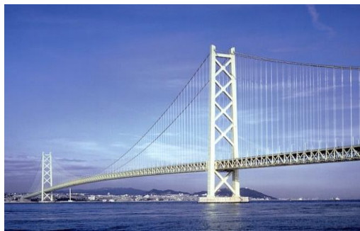
吊橋（明石海峡大橋）
