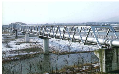
水管橋（雫石川水管橋）
