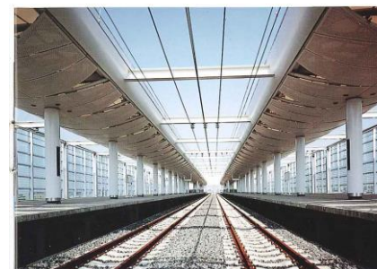
駅舎コンコース（八千代緑が丘駅）
